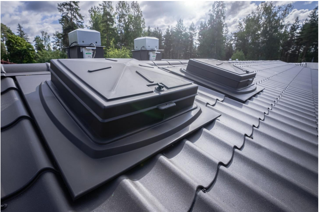
Kuvat 11. Plastec kattoluukku asennettuna tiilikuviopellille
