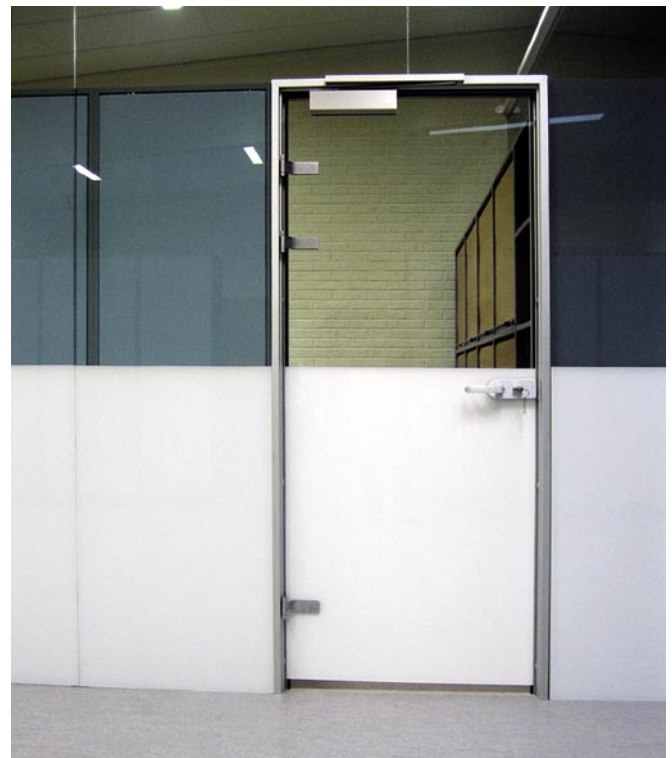
JT-lasiovi 4+4 karkaistua, laminoitu värikalvoilla, toimiston lasiseinällä. Kolmella saranalla, alumiinikarmilla, lukittavalla painikkeella ja ovipumpulla.
